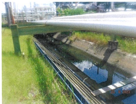
ภาพที่ 2-39 การทำคูป้องกันบริเวณแนวท่อขนส่ง Vent Gas และ Nitrogen
