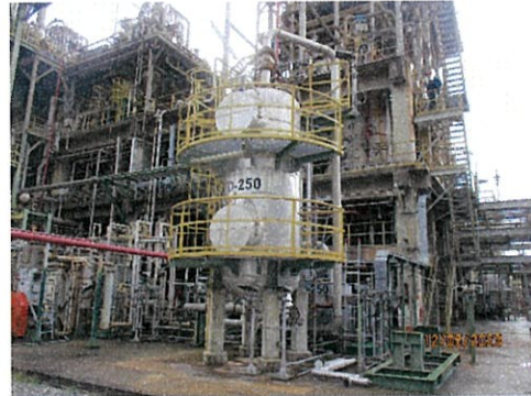
ภาพที่ 2-26 Hydrogenation Drum
