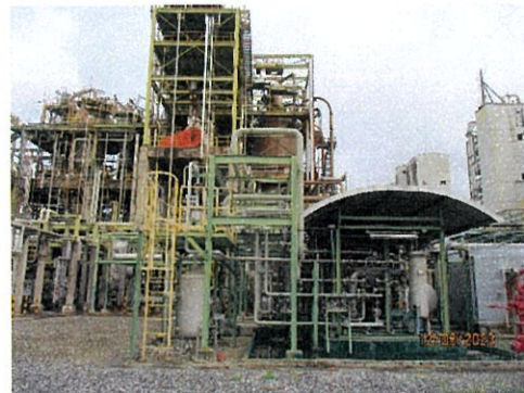
ภาพที่ 2-6 หน่วนำกลับไอสารไฮโดรคาร์บอน (VOC Recovery Unit: VRU) ของโรงงานที่ 2
